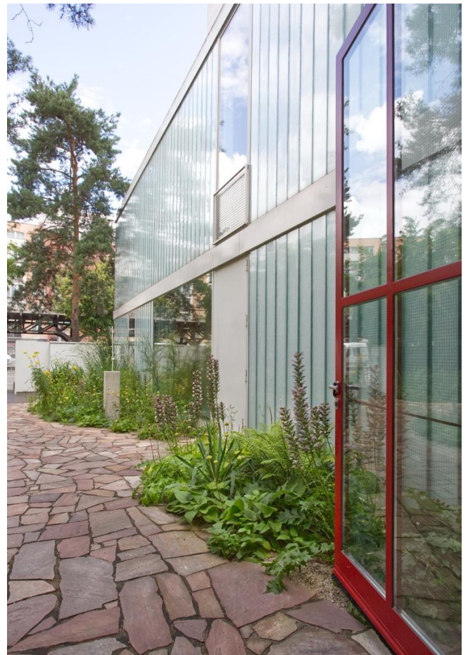
上：印象的なシャンデリアは、Martin Elsässer と Ernst May が 1950 年代にデザイン。下左：カフェに続く廊下は本アートブックコーナーに。 下右：増築部分。透光断熱材を組み込んだ二重構造産業ガラス製ファサードは柔らかく光を反射し、レトロな建物や庭の雰囲気を変えない。
