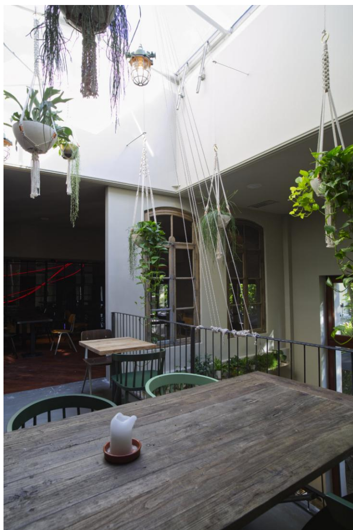
レストラン空間の一部に残された中二階。縮小し下の壁を取り払ったが、建物を支える壁の一部だったため大変だったという。
