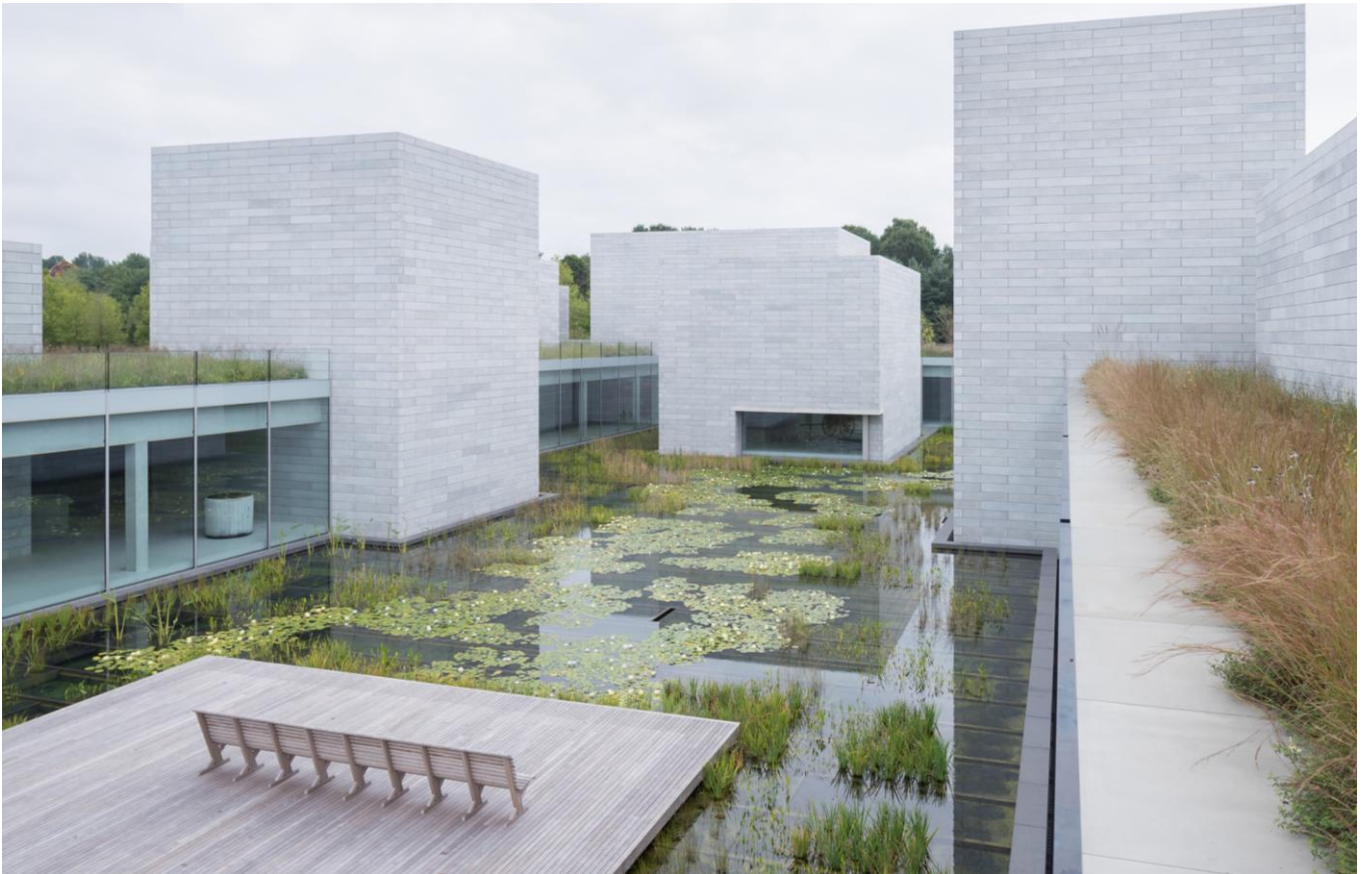
Water Court を囲むように建てられた新設パビリオン館
